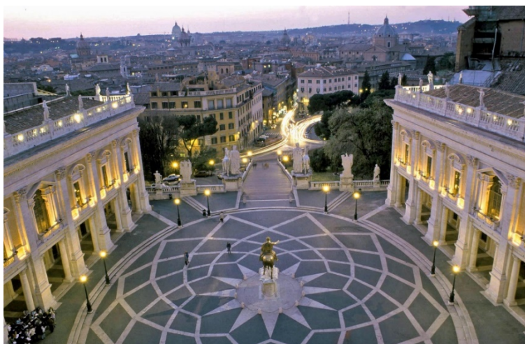
Figura 20 - La convergenza delle pareti verso l'apertura panoramica
