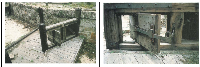
Figura 6 – Particolare della porta e del portello di regolazione del deflusso dell’acqua
