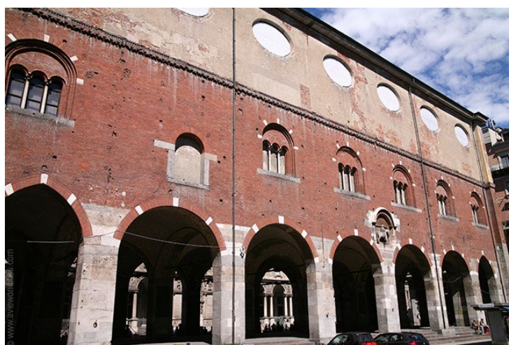
Figura 3 – La facciata su piazza dei Mercanti
