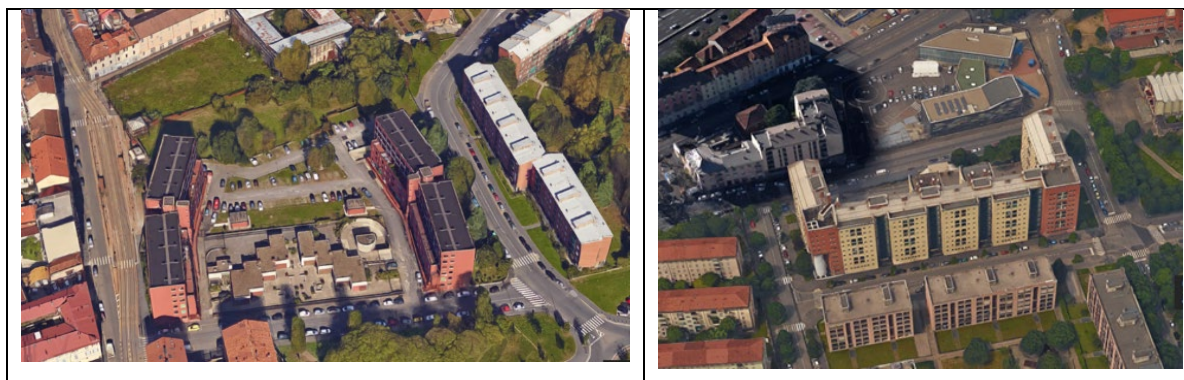
Figura 16 Il Complesso residenziale a Niguarda e l'Unità residenziale a Vialba
