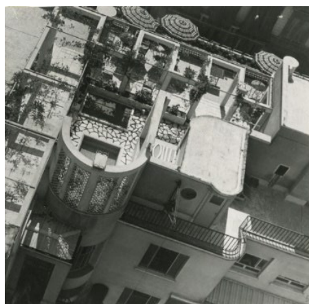
Figura 13 - La copertura a terrazza della Torre Rasini
