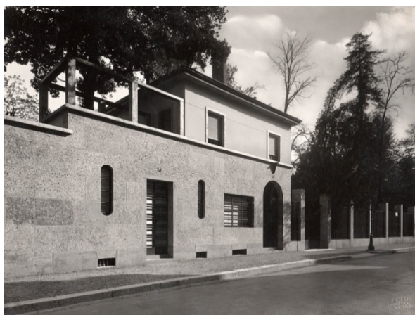
Figura 20 - Piero Portaluppi. Villa Necchi Campiglio. La recinzione e il corpo di fabbrica sulla via Mozart
