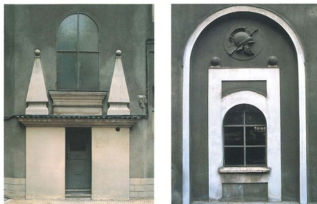
Figura 14 - La Ca' Brütta. Portale all'interno del cortile e finestra su via dei Cavalieri.
