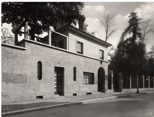
Figura 14 - Piero Portaluppi. Villa Necchi Campiglio. La recinzione e il corpo di fabbrica sulla via Mozart
