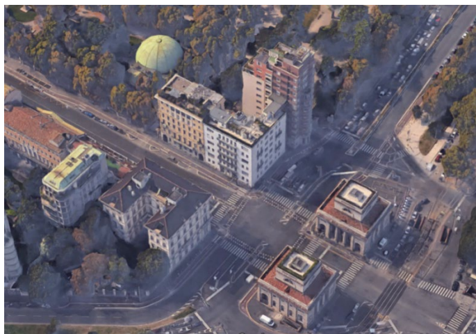
Figura 4 – Casa e Torre Rasini. Il contesto urbano
