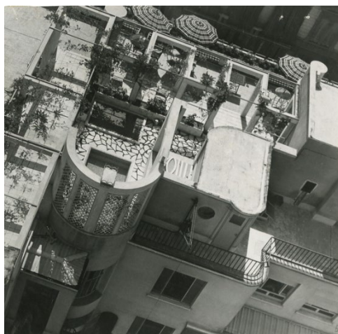
Figura 6 - La copertura a terrazza della Torre Rasini
