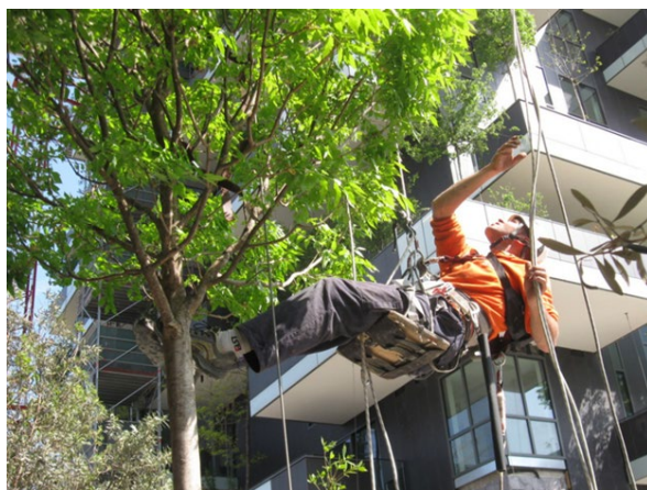
Figura 36 – Il sistema di manutenzione del Bosco Verticale.
