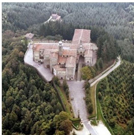
Figura 7 - L'Eremo di Montesenario, ubicato a circa 20 chilometri da Firenze, costruito in onore dei sette santi fondatori dell'ordine mendicante dei Servi di Maria
