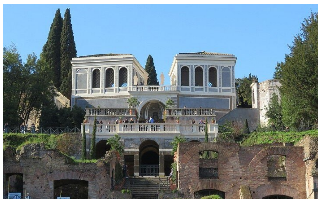
Figura 13 - Le uccelliere e il Ninfeo della Pioggia dopo il restauro (2013-2018).
