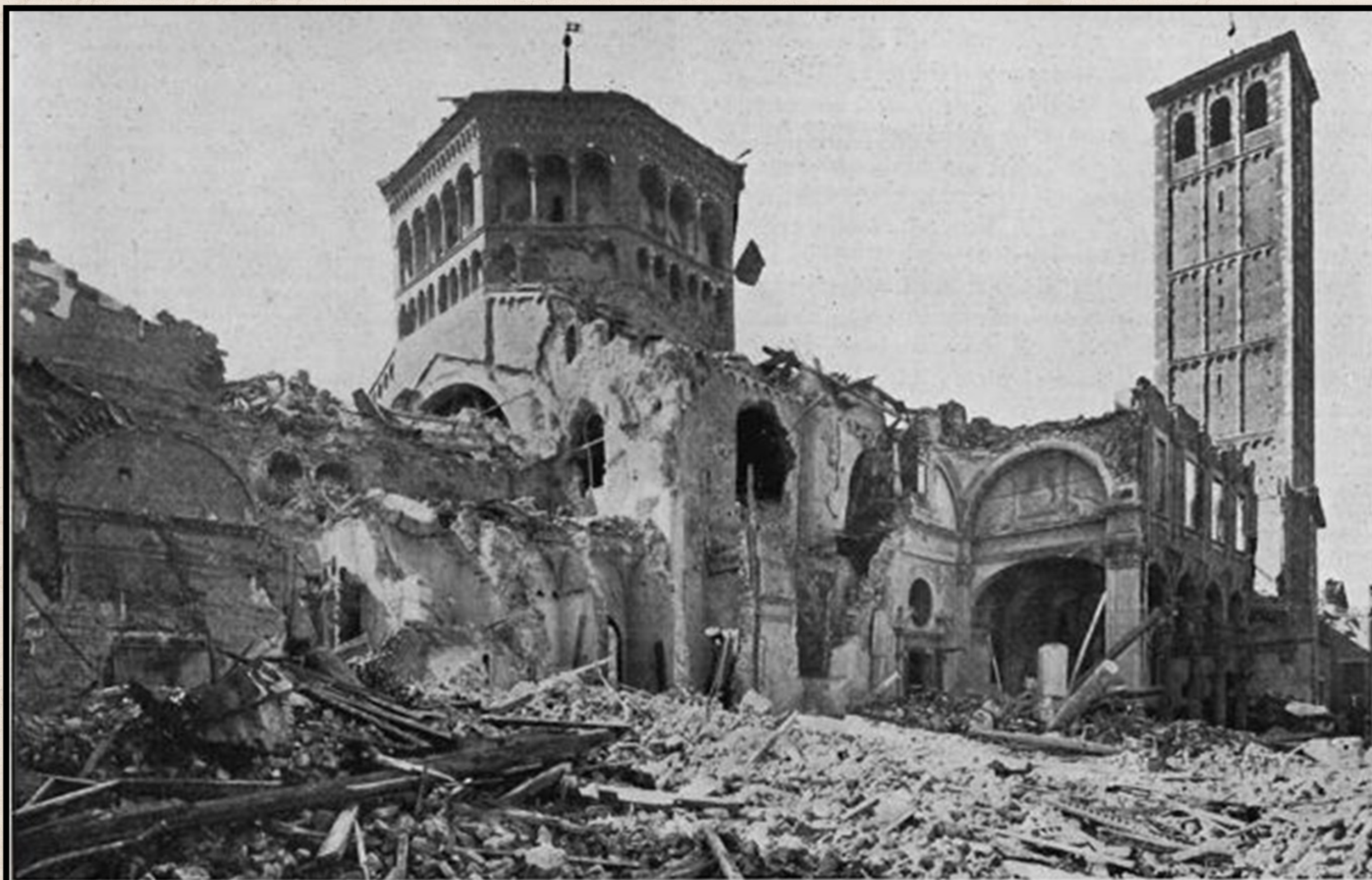
FIG. 4 - MILANO, BASILICA AMBROSIANA - LATO SINISTRO, IL MATTINO DEL 16 AGOSTO 1943: APPARE QUASI COMPLETAMENTE DISTRUTTO IL PORTICATO DELLA CANONICA DEL BRAMANTE
